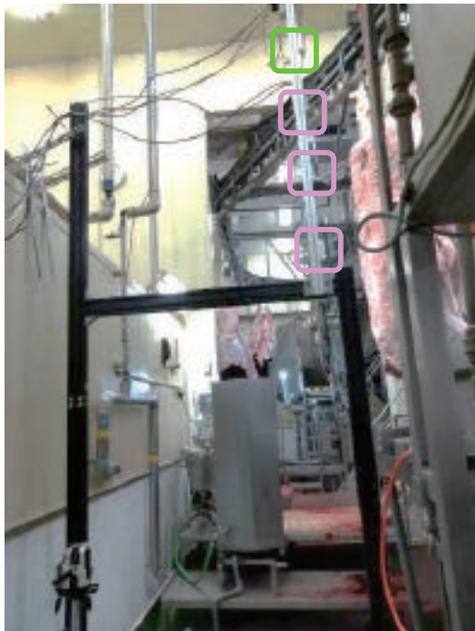
Fig.7 アルミフレーム全体
