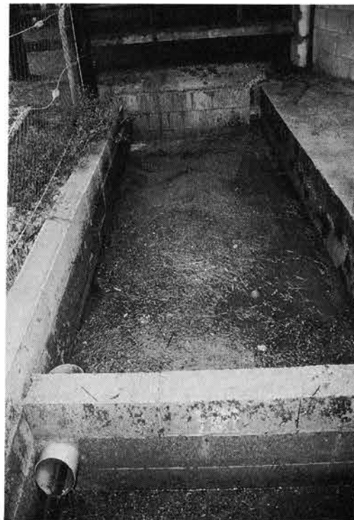
ミルク・パーラーの排水を沈殿槽に導き、上澄みはパイプで草地に散布。
