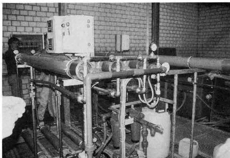
メタン発酵廃液を処理する逆浸透膜装置
