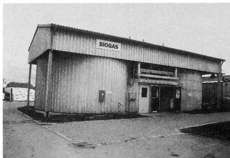
メタン発酵施設（左は木製、右はコンクリート製）
